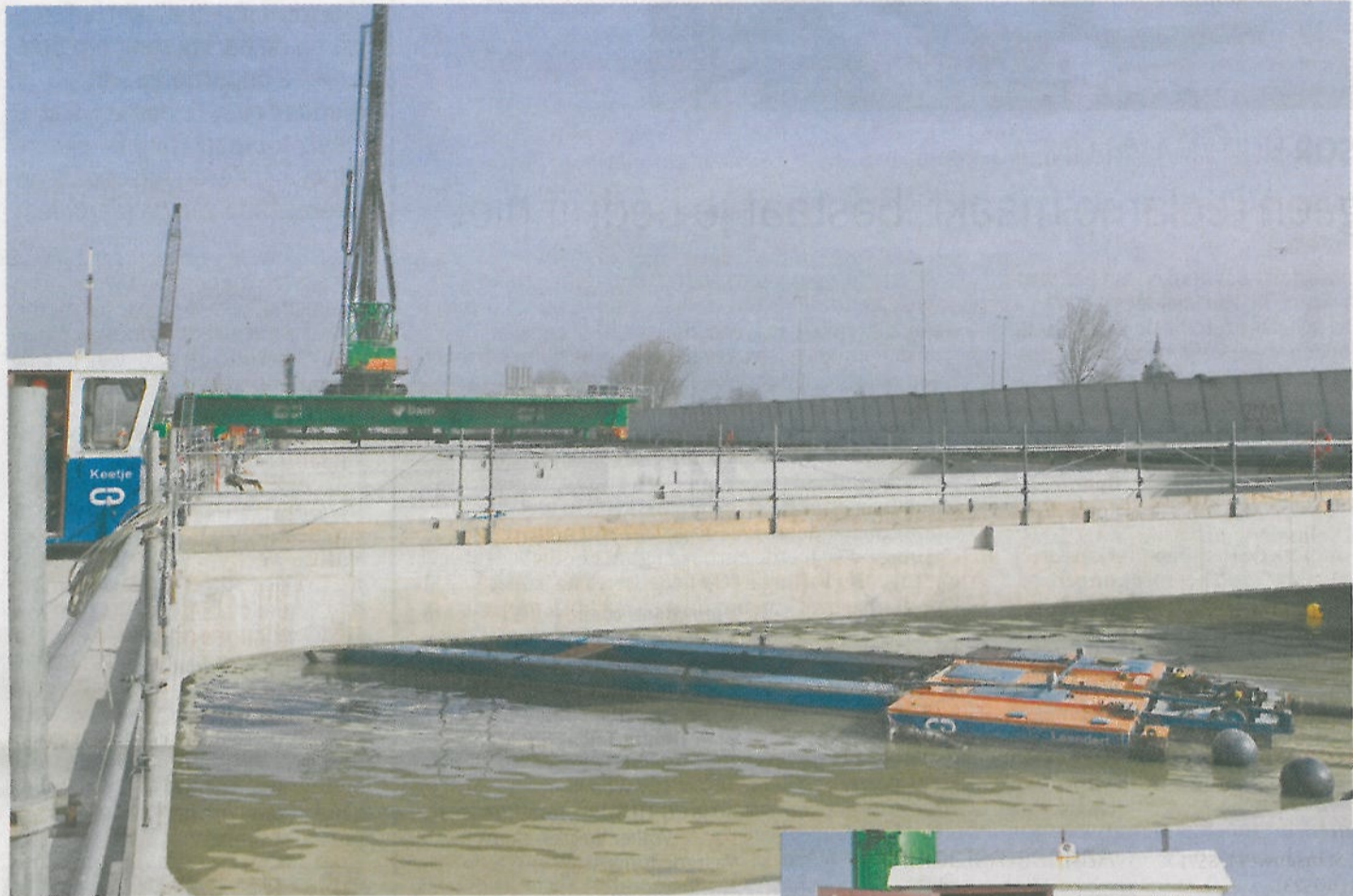
De bodem van de verdiepte ligging van de A4 bij Leiderdorp wordt tot op 5 centimeter nauwkeurig in profiel gebracht. Foto's: Peter van Mulken
